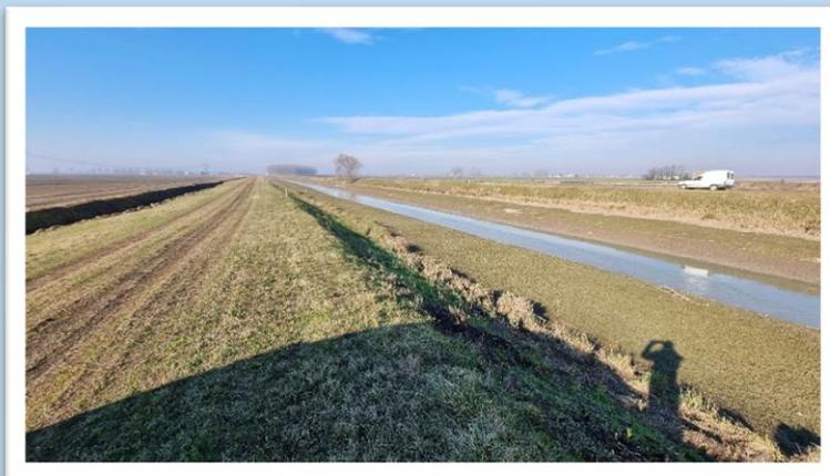
I lavori, in prosecuzione di quelli realizzati l'anno precedente, sono consistiti nel risezionamento della Fossa Molinella, che nella parte medio bassa del suo percorso è caratterizzata da erosioni delle sponde, da fenomeni di deposito che di fatto ne riducono l'efficienza idraulica e da tratti in cui gli argini risultano insufficienti a contenere i livelli di piena.
