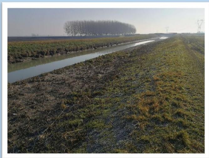
I lavori hanno avuto come obiettivo il risezionamento ed il consolidamento di sponda della Fossa Molinella che nella parte medio bassa del suo percorso è caratterizzata da erosioni delle sponde, da fenomeni di deposito che di fatto ne riducevano l'efficienza idraulica e da tratti in cui gli argini risultavano insufficienti a contenere i livelli di piena.
